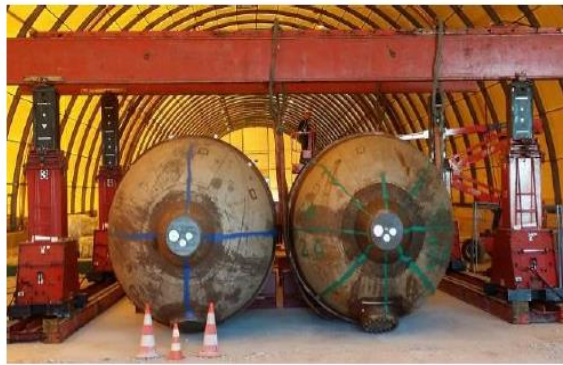
図6 蒸気発生器の埋設処分の状況
