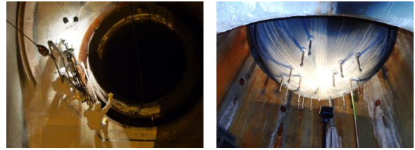
図5 容器底部の一次系配管の切断（左図）及び取り除く断熱材（右図）
