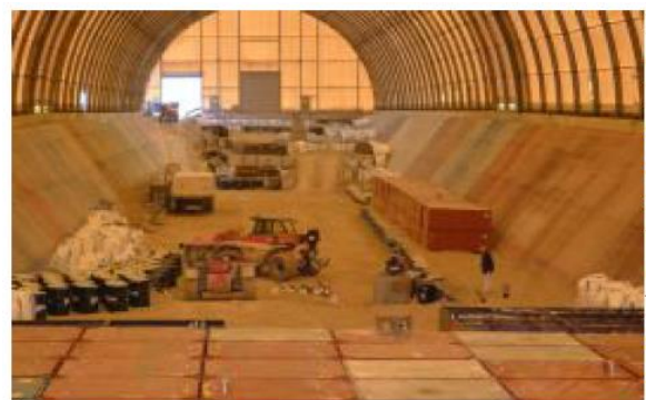
図 5 埋設処分用セル内での廃棄物静置の状況
